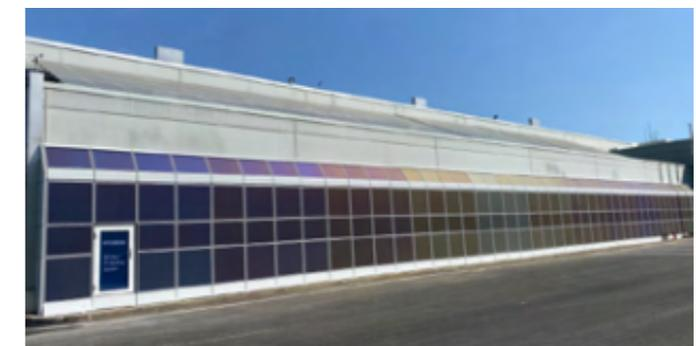
음성공장에 설치된 건물일체형 태양광 발전 시스템
